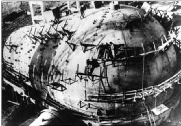
Рис. 4. Общий вид монтажа воздухонагревателя
