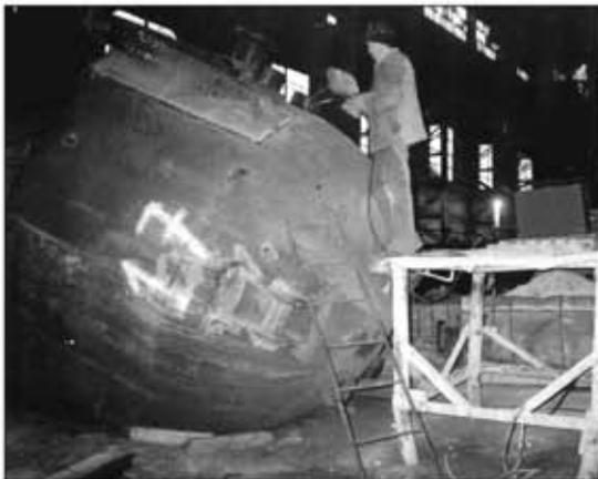
Рис. 4. Ремонтная сварка порошковой проволокой ПП-АН7 металлургического оборудования на ОАО «Днепропетровский металлургический комбинат им. Ф. Э. Дзержинского», г. Днепропетровск [5]
