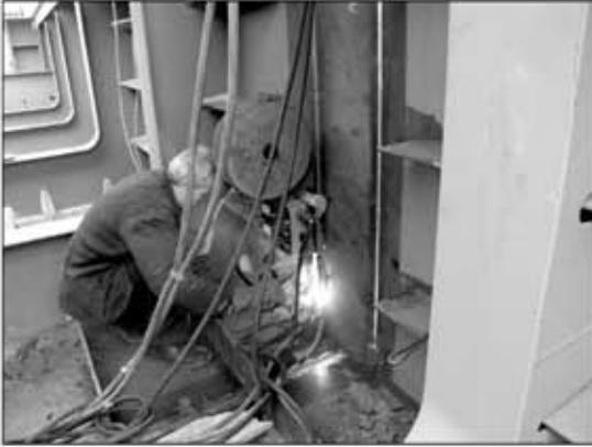
Рис. 5. Сварка порошковой проволокой ПП-АН9Н с принудительным формированием вертикальных стыковых швов пролетных конструкций Подольско-Воскресенского мостового перехода через р. Днепр в г. Киеве
