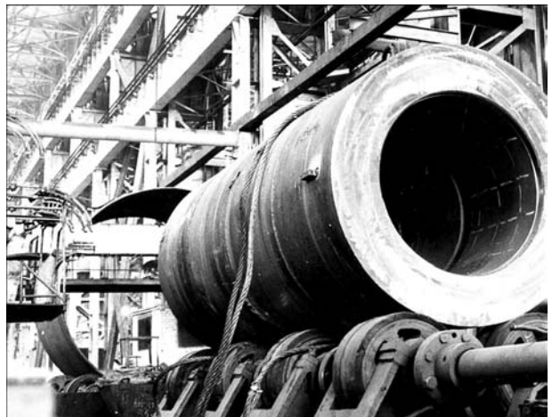
Рис. 11. Электрошлаковая сварка корпуса транспортного контейнера ТК10 из толстостенных обечаек с припаянной нержавеющей футеровкой
