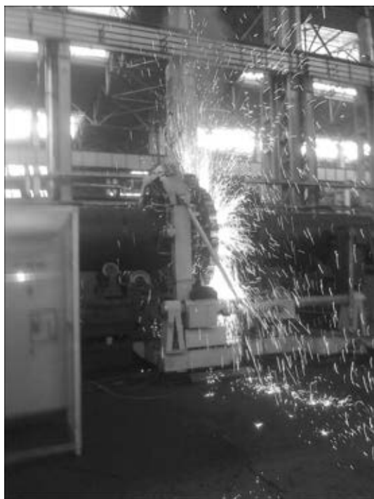
Рис. 16. Комплекс для контактной стыковой сварки оплавлением морских трубопроводов диаметром 1219 мм с толщиной стенки 27 мм
