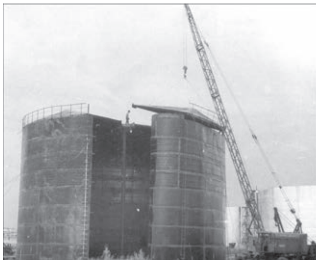
Монтаж крупногабаритного резервуара (1948 г.)
