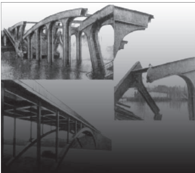
Рис. 2. Руйнування зварного моста через канал Альберта (1938)
