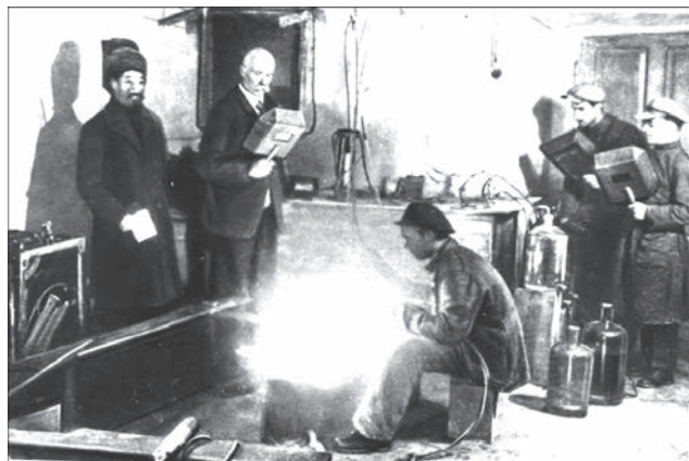
Рис. 1. Атомно-водневе зварювання в ІЕЗ
