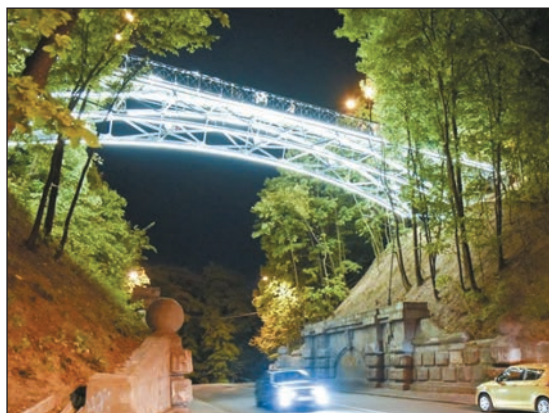
Арочний міст над алеєю Магдебурзького права у м. Києві, побудований у 1910
