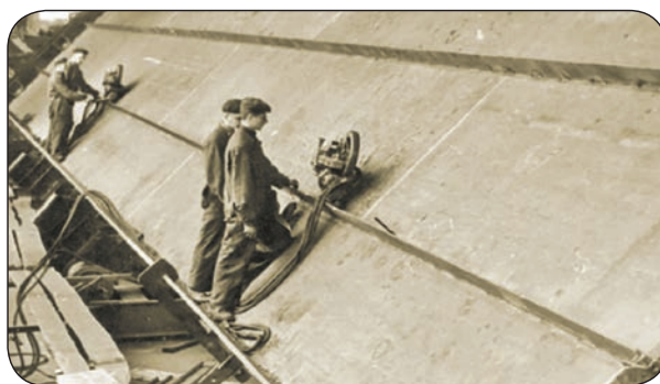
Зварювання балки мостового перекриття, м. Дніпропетровськ (1952 р.)
