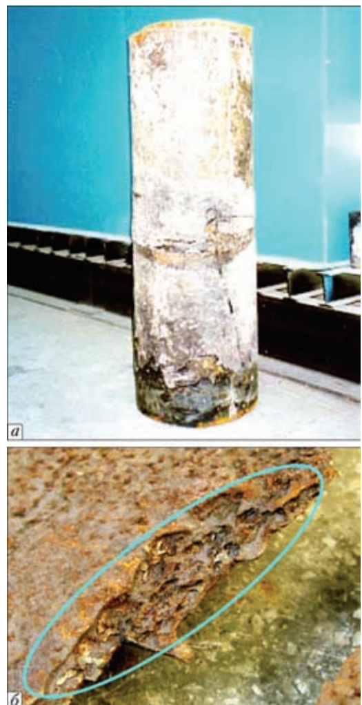
Рис. 1. Элемент трубы после длительной эксплуатации (а) и поверхность разрушения (б)
