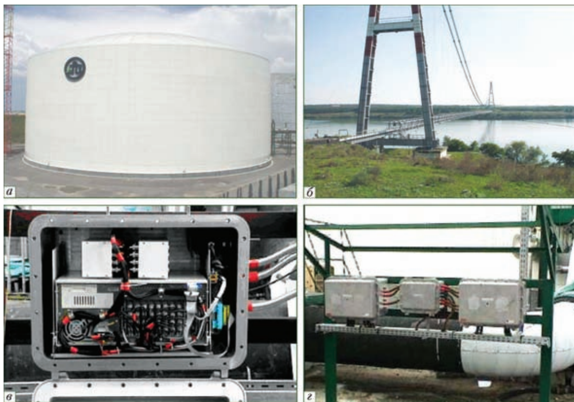
Рис. 3. Системы непрерывного АЭ мониторинга хранилищ жидкого аммиака и мостовой переход аммиакопровода через р. Днепр: а — хранилище аммиака ОПЗ; б — аммиакопровод на мосту через р. Днепр; в — измерительный блок системы АЭ мониторинга в период монтажа; з — система АЭ мониторинга после герметизации в специальных взрывопожаробезопасных контейнерах с климатконтролем
