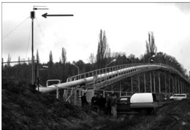
Рис. 4. Мачта с солнечной батареей (показана стрелкой) и выносной антенной GSM модема в начале компенсатора мостового перехода
