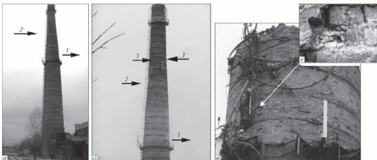
Рис. 3. Основные факторы, действовавшие на ствол кирпичной трубы до обрушения и ставшие причинами обрушения: отклонение оси ствола от вертикали (крен) на отметке +45 м (1) составляет 220 мм (для труб высотой до 100 м допускается 0,002 высоты, но не более 150 мм*), изгиб ствола относительно вертикали (2) (а); образование наледей (3) на кирпичной кладке в верхней части ствола вследствие эксплуатации при неполном режиме работы котлов (б); во время обследования – стрелкой обозначены места увлажнения и массового разрушения (выпадения) кирпича из кладки (в, г)
