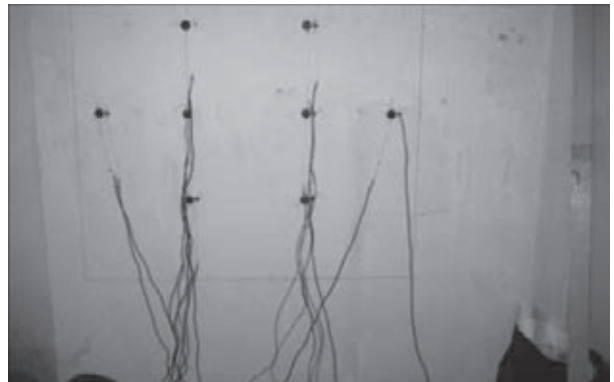
Рис. 5. Расположение температурных датчиков
