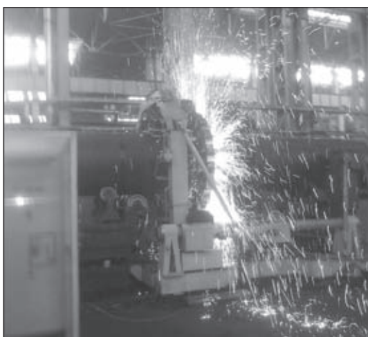
Рис. 16. Комплекс для контактной стыковой сварки оплавлением морских трубопроводов диаметром 1219 мм с толщиной стенки 27 мм
