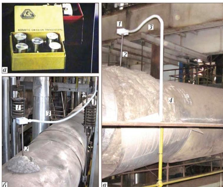
Рис. 3. Установка АЭ датчиков (а) на трубопроводе: датчик 1 в специальном коробе, установленном на приваренном к трубопроводу волноводе 2; соединительный кабель в гибкой изоляции 3 (б), в жестком коробе 4 (в)
