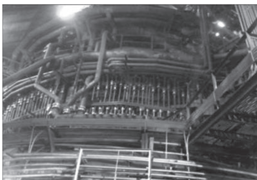
Рис. 3. Металлоконструкции и элементы СИО участка шахты печи
