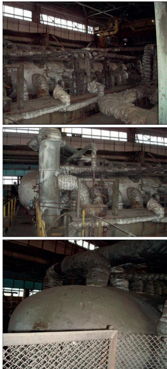
Рис. 1. Внешний вид барабана котла ТГМ-96
