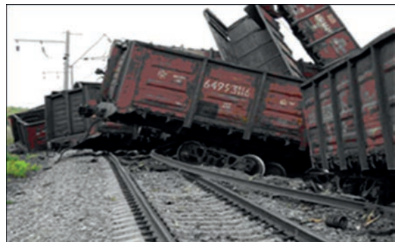
Рис. 1. Авария на Западно-Сибирской дороге (РФ). Излом рельса
