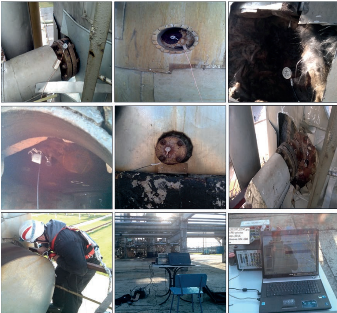
Рис. 3. Установка датчиков и подготовка оборудования для проведения АЭ контроля
