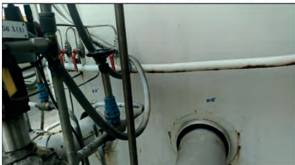
Рис. 2. Визначення місць для встановлення датчиків АЕ (вибірково)
