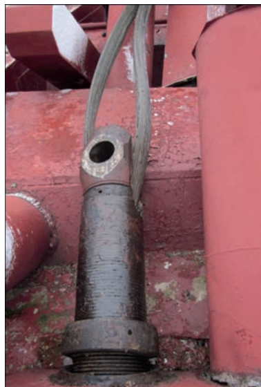
Рис. 1. Закріплення канату
