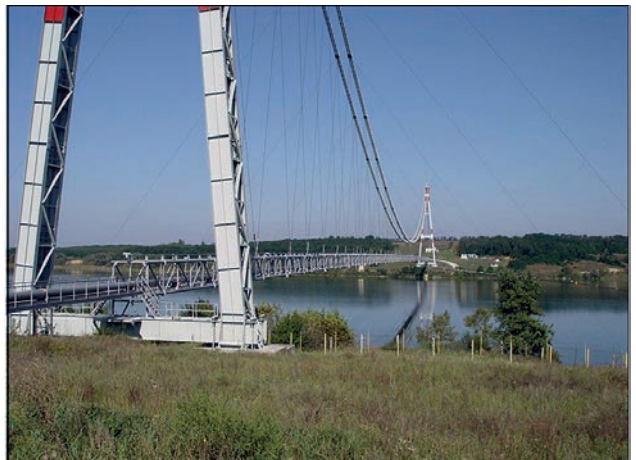
Рис. 9. Кілометрова ділянка магістрального аміакороводу Тольятті–Одеса на мосту через р. Дніпро
