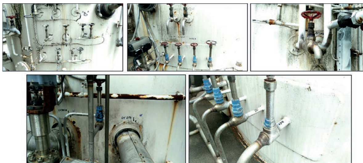
Рис. 11. Підготовка місць для встановлення датчиків АЕ (вибірково)
