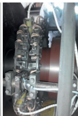
Встановлення датчиків на щітково-контактному апараті турбоагрегата
