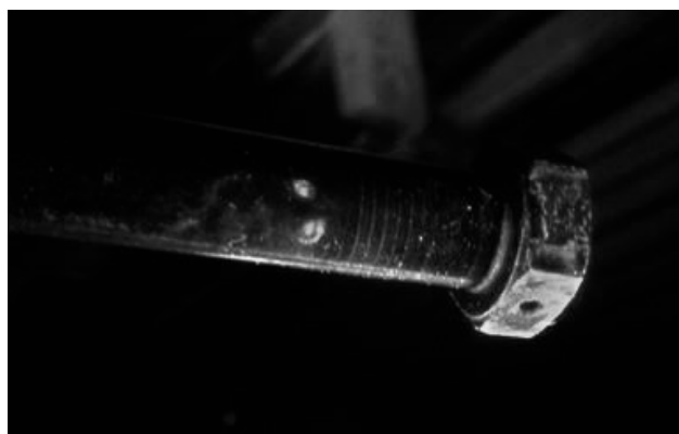
Fig. 1. Schematic indication of cracks on a propeller mounting bolt Рис. 1. Індикація (сліди) тріщин на болті кріплення повітряно-го винта.
