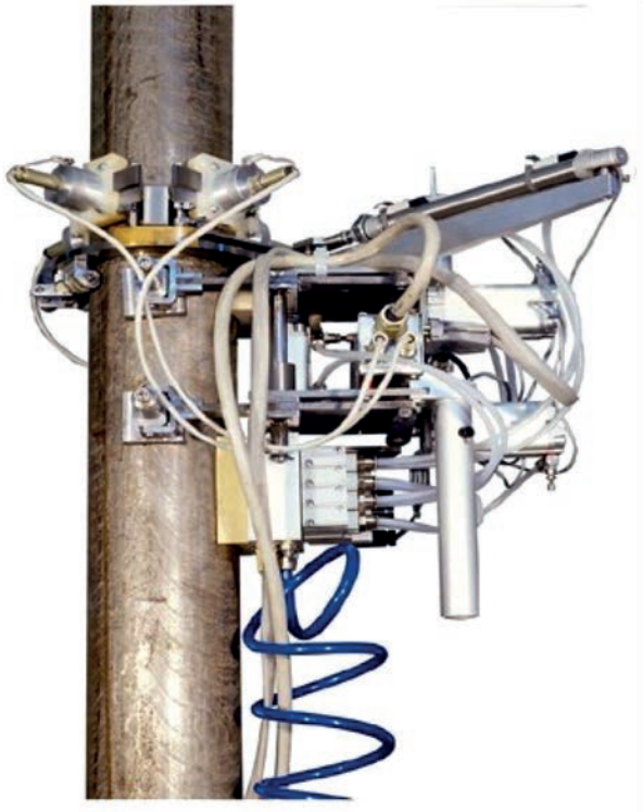
Рис. 3. Сканер ВС системи «КРАБ», встановлений на трубі печі вторинного риформінгу
