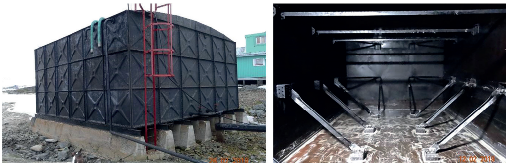
Рис. 2. Резервуар РГС-150. Вид зовні та зсередини
