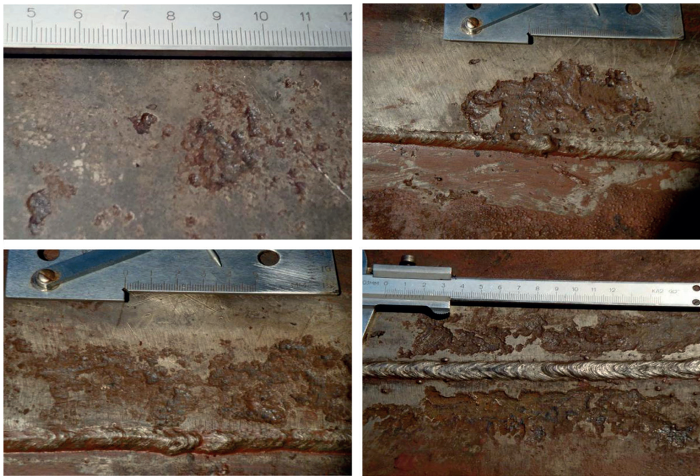
Рис. 3. Загальний вид корозійних пошкоджень днища
