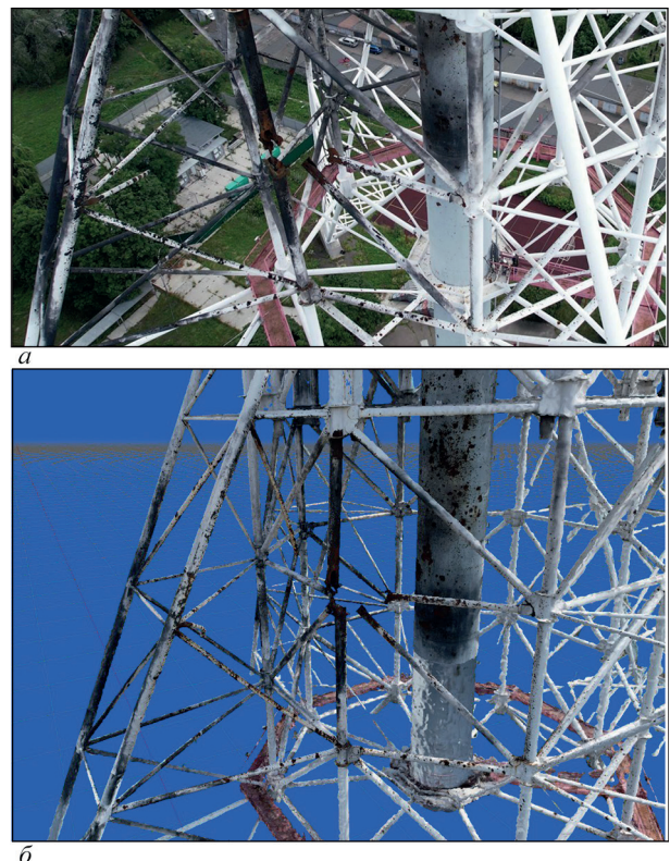
Рис. 4. Ділянка телевежі епіцентру вибуху: a – фотографія; б – тривимірна модель
