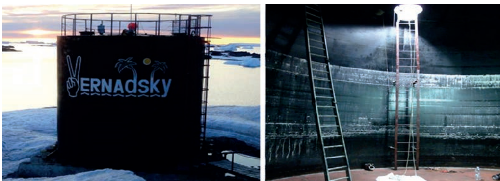
Рис. 1. Резервуар РВС-200. Вид зовні та зсередини
