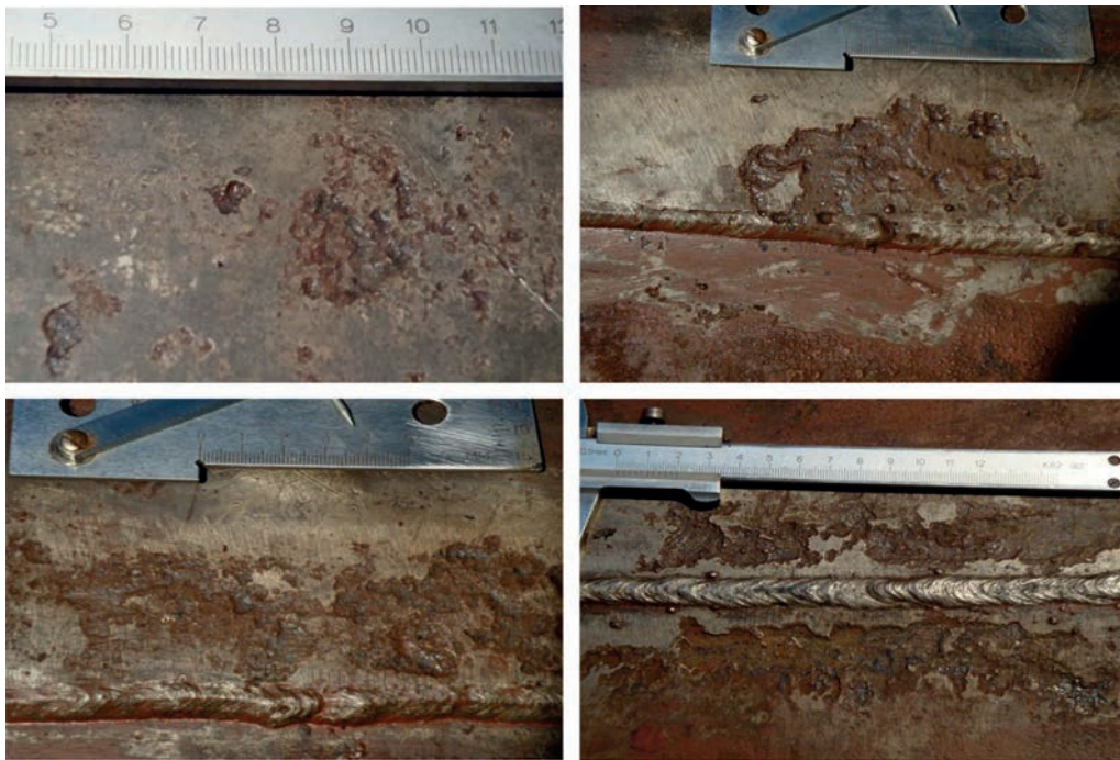
Рис. 3. Загальний вид корозійних пошкоджень днища
