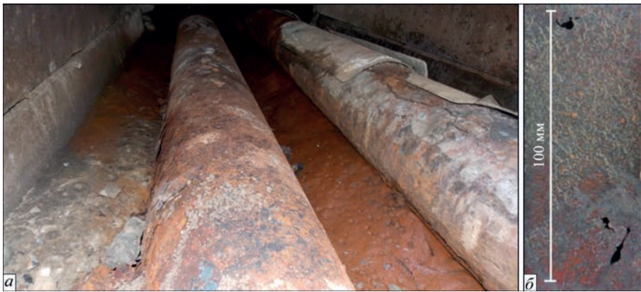
Рис. 1. Подавальний і зворотний трубопроводи в непрохідному каналі (а); наскрізні корозійні пошкодження подавального трубопроводу (б)
