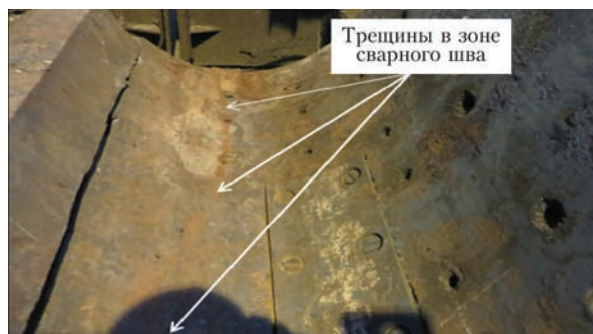
Рис. 2. Увеличенные участки с трещинами в зоне сварных швов
